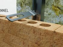
4. EMBED TIE INTO MORTAR JOINT.
